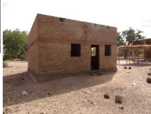
Salle de classe en construction
